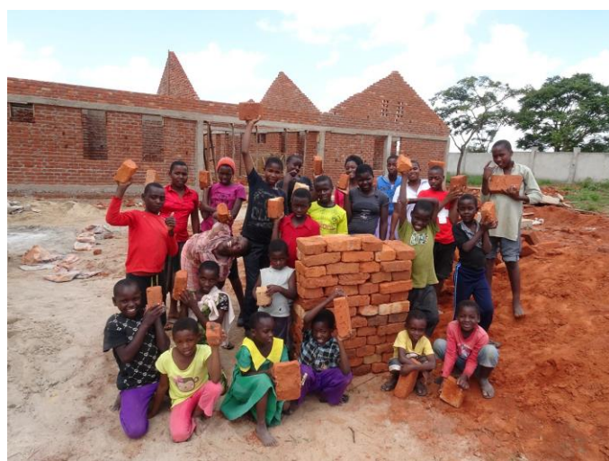
孤児院第2棟の建設風景と子どもたち（2017年竣工）
